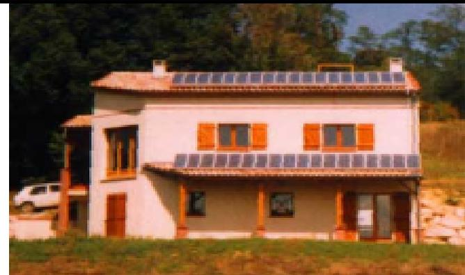
Exemple de sur imposition en toiture inclinée
