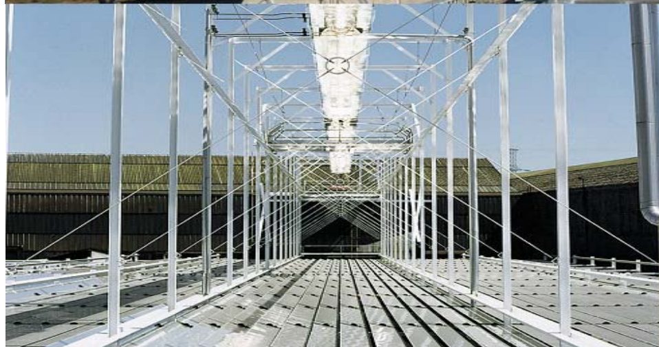
linear Fresnel 线性费涅尔(Solarmundo)
