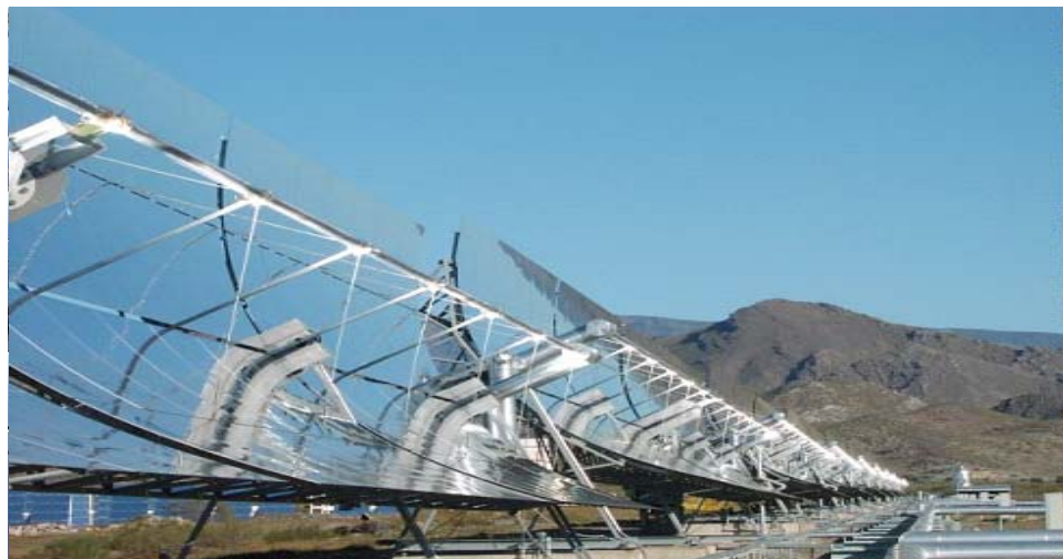
parabolic trough 抛物线槽式(PSA)
